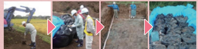
①汚染された土を除去 ②耐火袋につめる（線量測定） ③敷地内掘削 ④仮埋設
